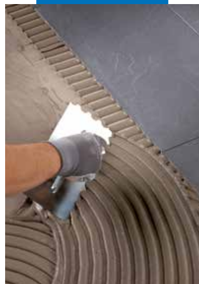
Intinderea adezivului cu spatula metalica dintata de 9 mm
