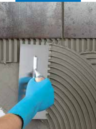
Intinderea adezivului cu spatula pe perete
