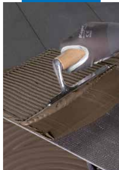
Aplicarea adezivului pe spatele placii
