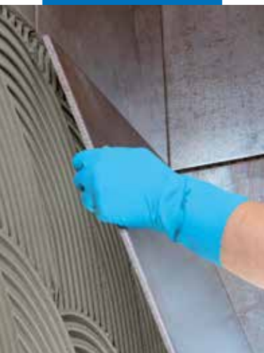
Montajul placii ceramice de dimensiune mare pe perete
