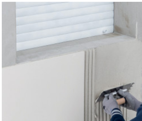
Montarea placilor ceramice de format mare
