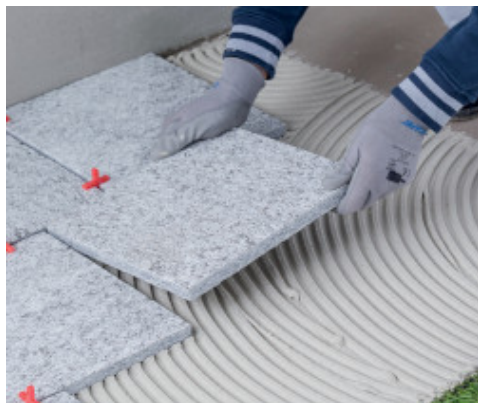
Montarea unor placi din piatra naturala la exterior
