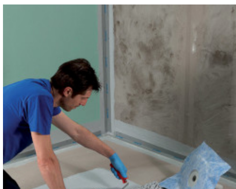
Aplicarea piesei de scurgere Drain Vertical utilizand Mapegum WPS
