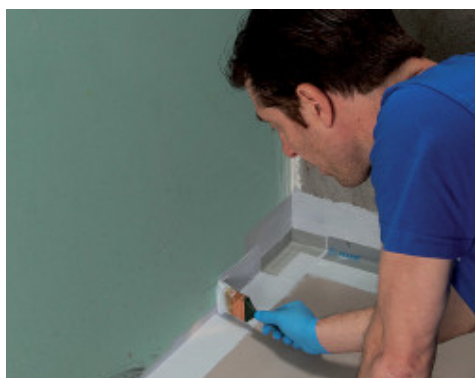
Aplicarea benzii Mapeband PE 120 folosind Mapegum WPS
