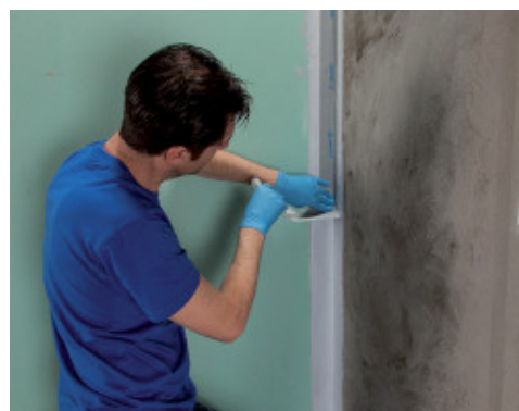
Aplicarea benzii Mapeband PE 120 folosind Mapegum WPS
