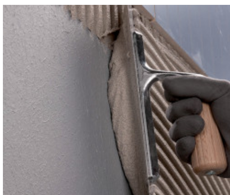
Montarea placilor ceramice pe pardoseli utilizand Ultramastic III
